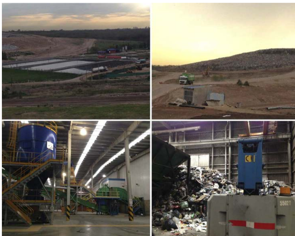
Planta de Tratamiento de líquidos lixiviados, Relleno Sanitario, Planta de Separación y clasificación de residuos. Fuente – Visita al CEAMSE octubre 2015
