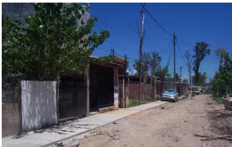
Figura 27. Mejorado de calle y veredas de H°. Tendido eléctrico.
