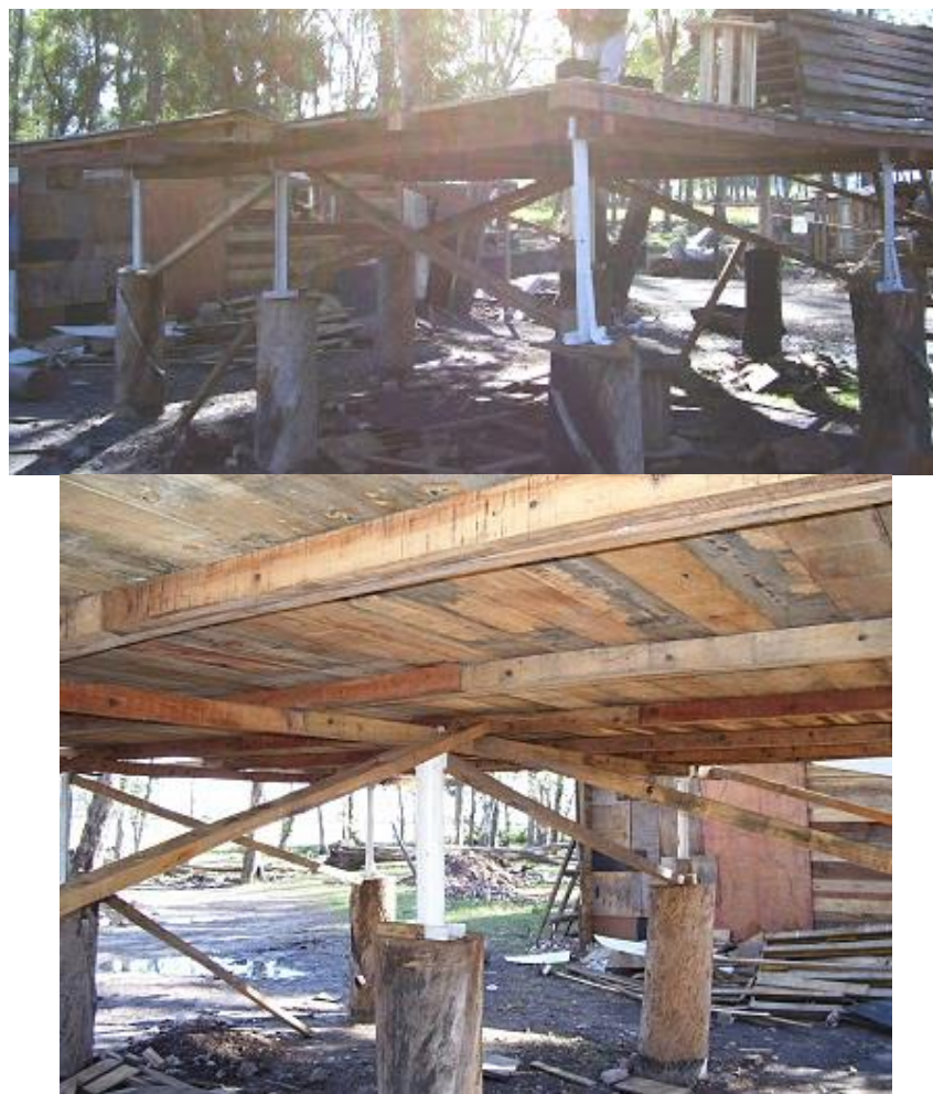
Figura 29. Utilización de los troncos de árboles del terreno (eucaliptos) para elevar las casas, a modo de pilotes, y prevenirse de la posible inundación.
