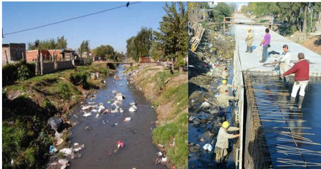
Figura 35 : Izquierda, arroyo todavía sin entubar. Derecha, obras de entubamiento del canal José L. Suárez Sur.
